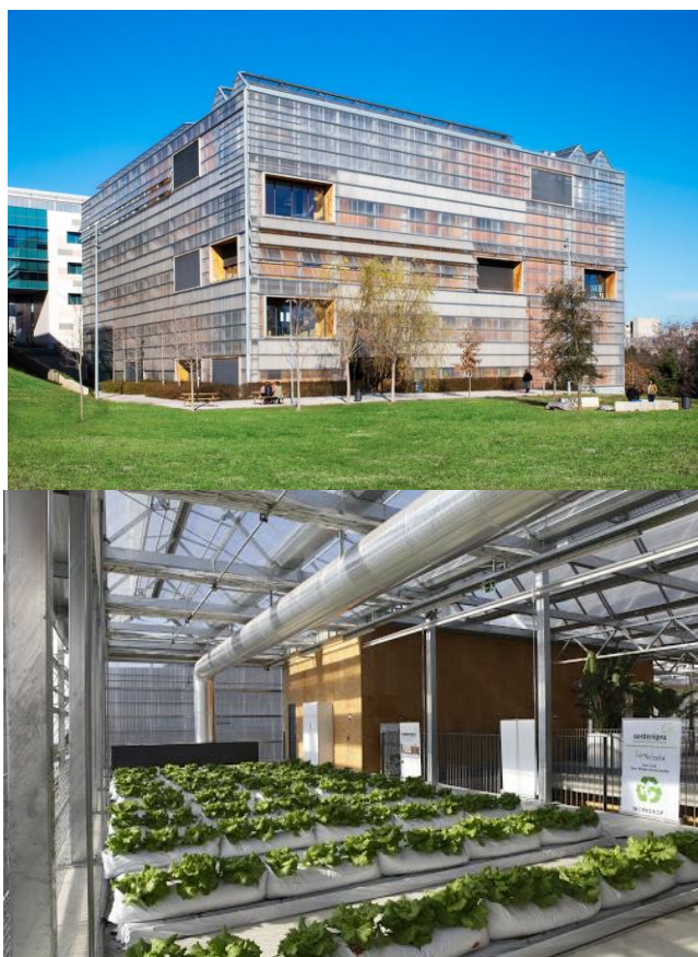
Figure 9. Serre sur le toit du bâtiment ICTA-ICP à Bellaterra (Espagne).
