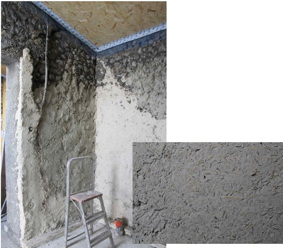
Scotch - Gobetis- corps d'enduit - finition
