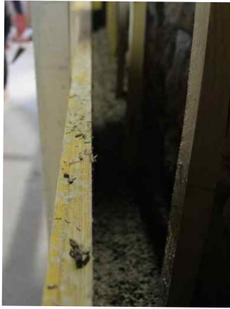
Ossature bois Coffrage – Béton de chanvre
